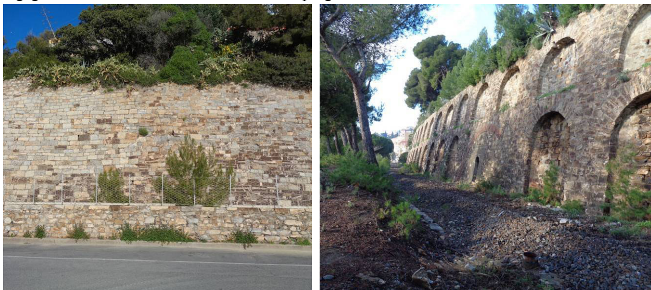
Figura 2 - muri di sostegno presenti lungo la tratta
